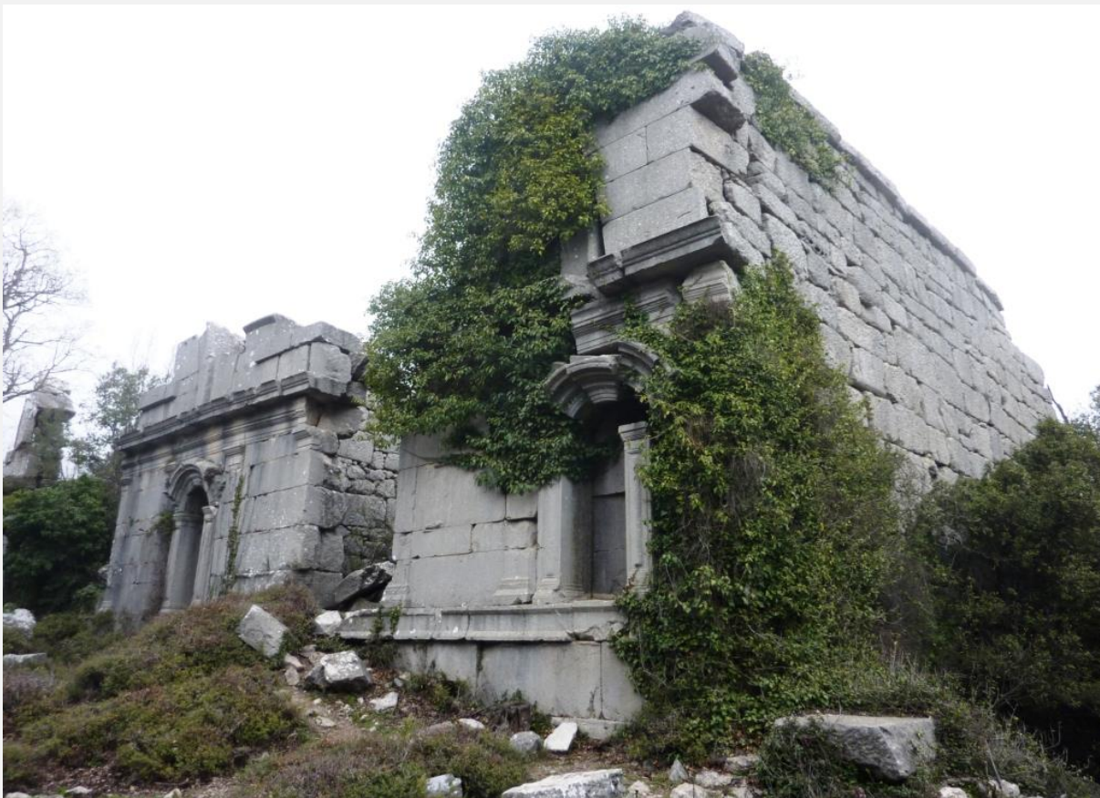
Φωτ. 5: Η ΒΑ πλευρά του Γυμνασίου. Μεγάλο τμήμα του πελώριου συγκροτήματος είναι ακόμα θαμμένο.
