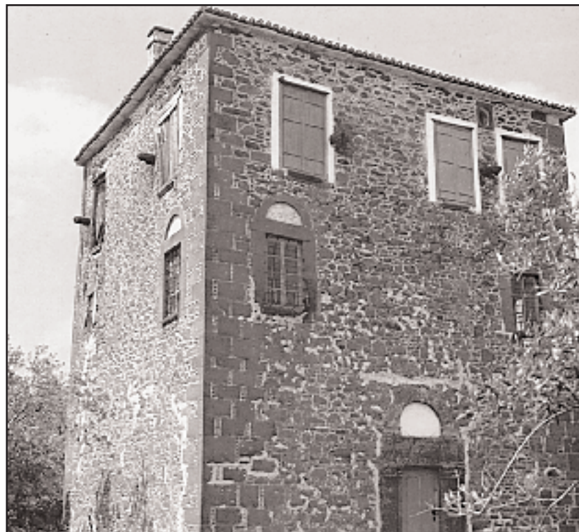
Πύργος του Καραπίπερη στους Πύργους Θερμής, από τους λίγους που είναι χτισμένοι μόνο με πέτρα. Ενδιαφέρον παρουσιάζει η διαμόρφωση του θυρώματος με τα λαξευτά αναγεννησιακά πιλάστρα και το ημικυκλικό τύμπανο, πρώιμο δείγμα επιρροής δυτικών στοιχείων. (Φωτ. «Λέσβος», εκδ. «Μέλισσα», Αθήνα, 1982).
