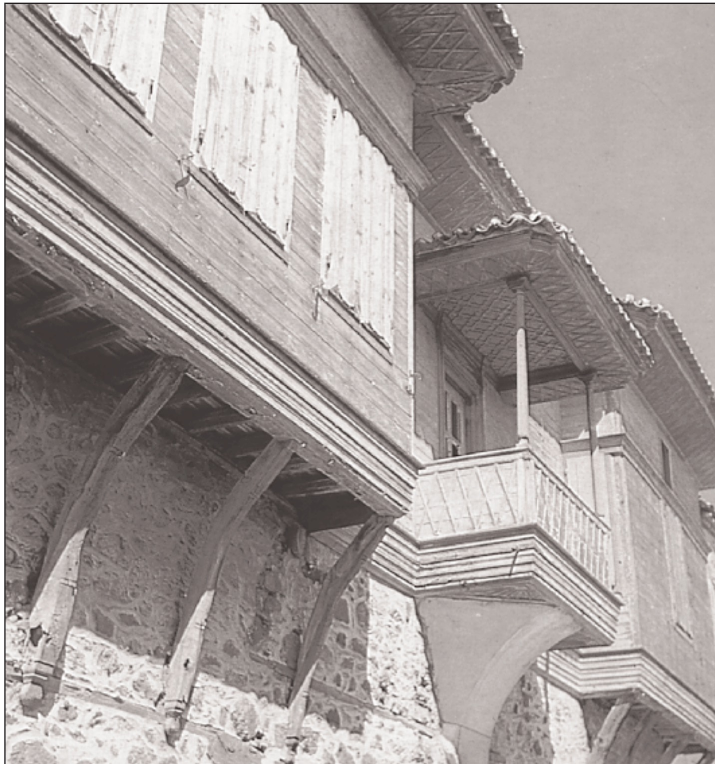
Το αρχοντικό της Βαρελτζίδαινας στην Πέτρα. Πρόσωση από το δρόμο. Στο μεγάλο λεπτοδουλεμένο γείσο της στέγης και στο πλαστικό σχήμα των φουρουσιών και του εξώστη η Κοντής διακρίνει την επίδραση του μπαρόκ.
