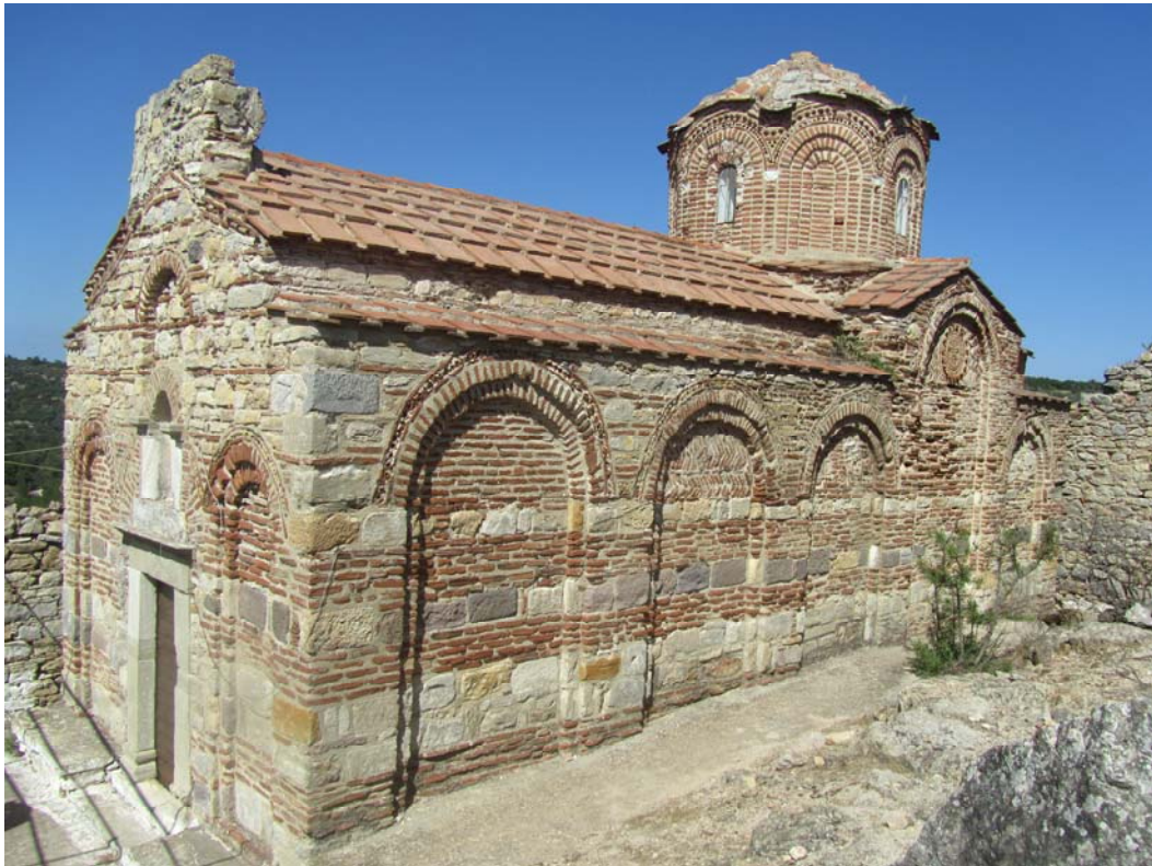
Νότια πλευρά: η μικτή τοιχοποιία και τα τυφλά αγιδώματα
