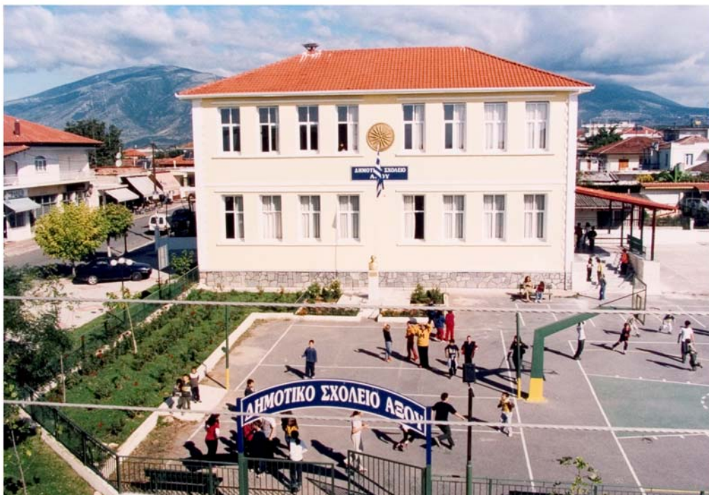
10. Το δημοτικό σχολείο της Αξού Γιαννιτσών στεγάζεται στο κτίριο του 1928, που έχει ανακαινιστεί (Αρχείο Αποστόλου Τσολάκη)
