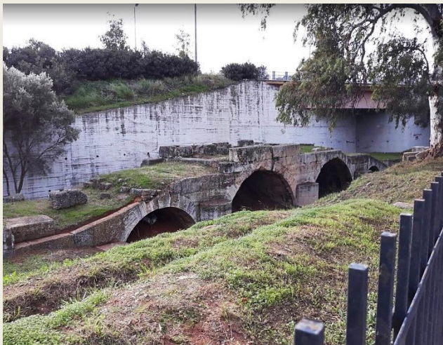
Η ρωμαϊκή γέφυρα
