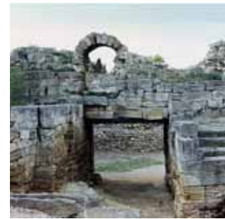
185. Πάνω ἀπὸ τὴν πύλη τοῦ ἑλληνιστικοῦ τείχους (3ος-2ος π.Χ. αἰ.) χτίστηκε μιὰ κωμαρωτὴ εἴσοδος τὸ 488 μ.Χ., ὅταν ὁ αὐτοκράτορας Ζήνων ἐδῶσε ἐντολὴ νὰ ἐπισκευαστοῦν τὰ ἀρχαῖα τείχη.
